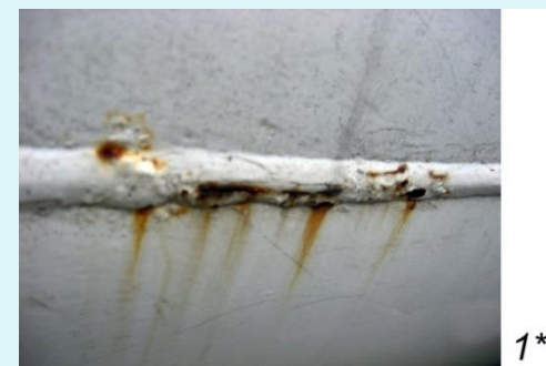
Hosszvarrat repedés
